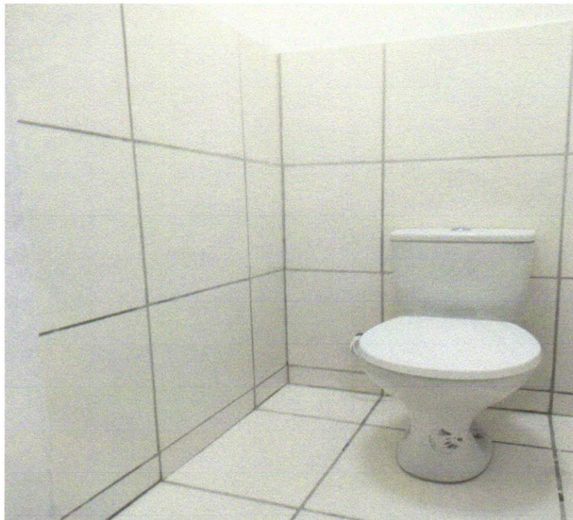
Foto 15 – REVESTIMENTO CERÂMICO PARA PAREDES INTERNAS COM PLACAS TIPO ESMALTADA EXTRA DE DIMENSÕES 33X45CM APLICADAS EM AMBIENTES DE ÁREA MAIOR QUE 5M2 A MEIA ALTURA DAS PAREDES. AF_06/2014
