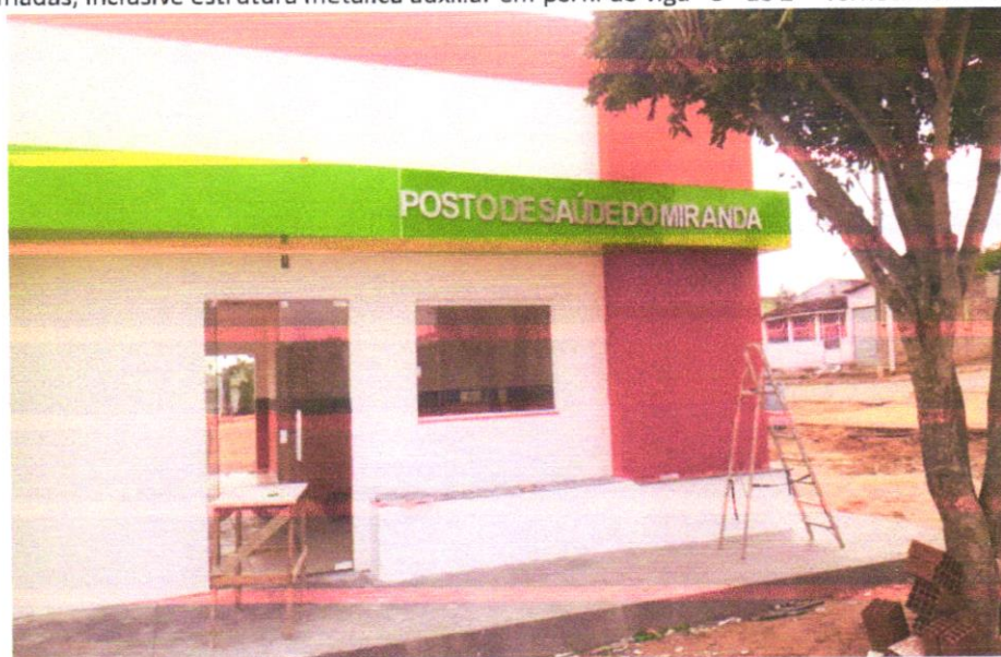
FOTO 02 –Letra em alumínio 20 x 20cm – instalado
