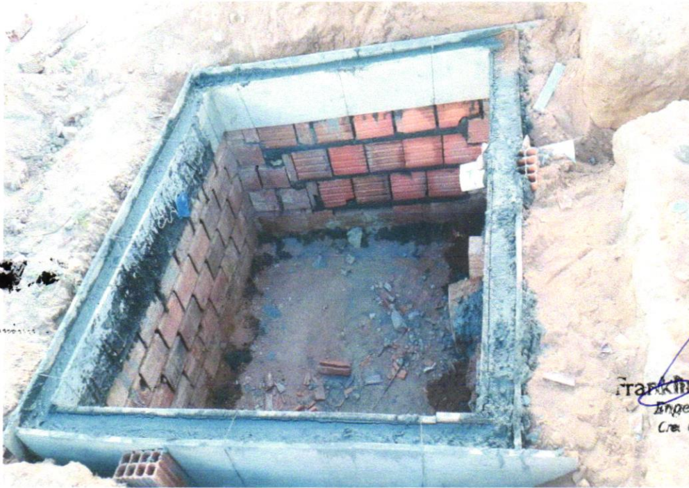
Foto 9 - Fossa séptica pré-moldada, tipo oms, capacidade 15 pessoas (v=900 litros)
