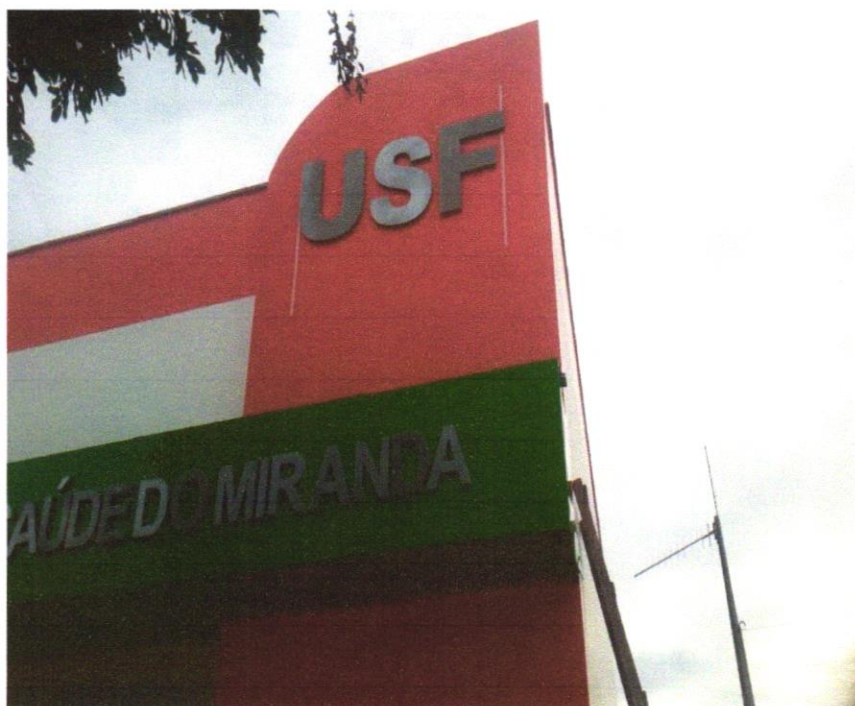
FOTO03-Letra em alumínio 45 x 45cm – instalado
