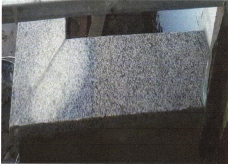
Foto 23 – SOLEIRA EM MÁRMORE, LARGURA 15 CM, ESPESSURA 2,0 CM. AF_09/2020
