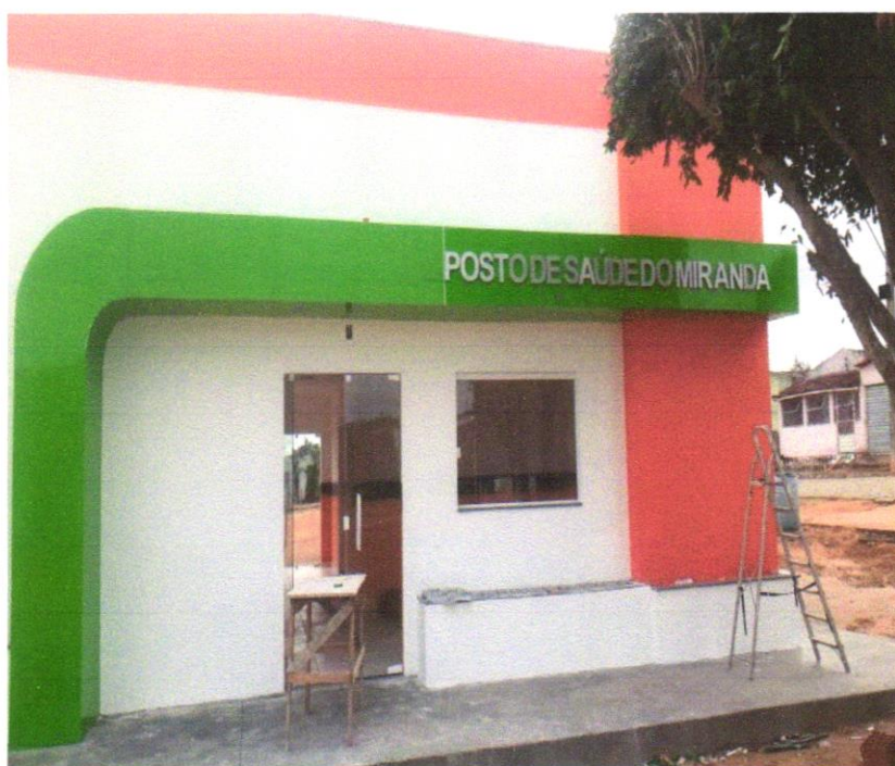
FOTO03-Letra em alumínio 45 x 45cm – instalado
