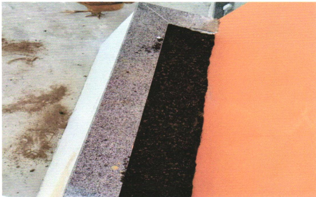
Foto 07- SOLEIRA EM MÁRMORE, LARGURA 15 CM, ESPESSURA 2,0 CM. AF_09/2020
