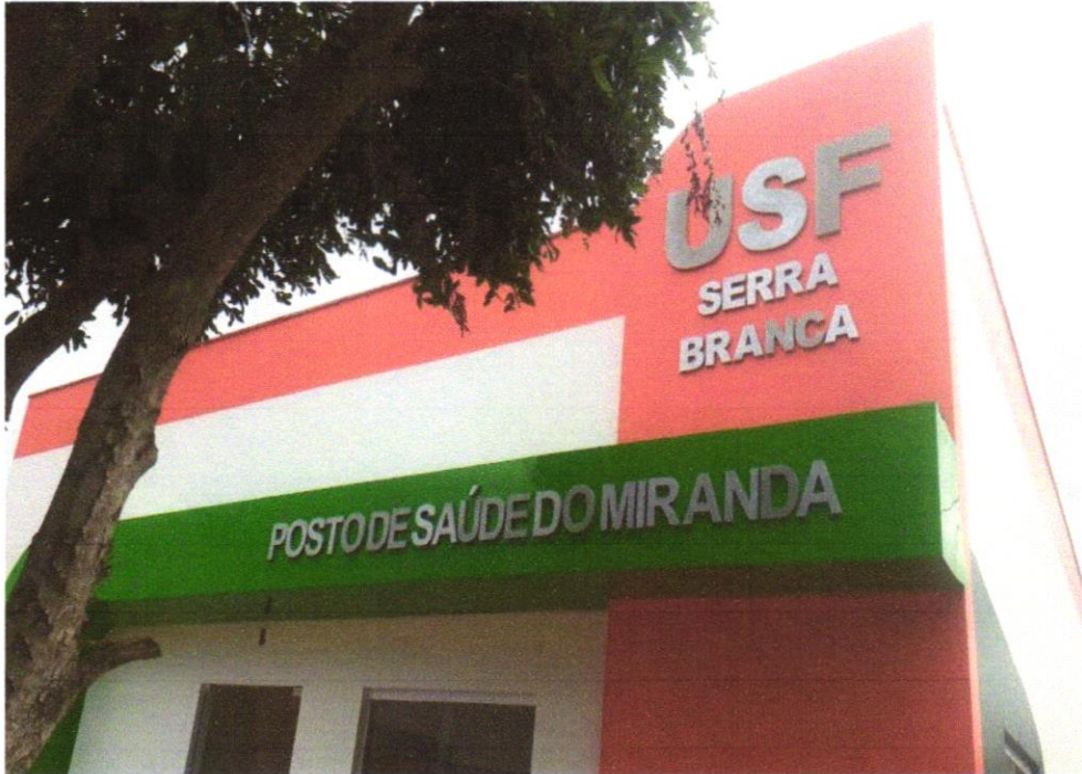
Foto 11- Letra em alumínio 15 x 15cm – instalado
