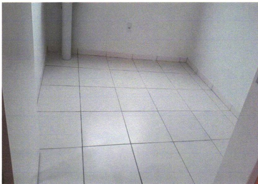
Foto 16 – RODAPÉ CERÂMICO DE 7CM DE ALTURA COM PLACAS TIPO ESMALTADA EXTRA DE DIMENSÕES 45X45CM. AF_06/2014
